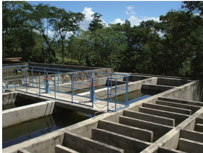
モラレス浄水場の沈殿池(右側手前)及び緩速ろ過池(左側奥)
