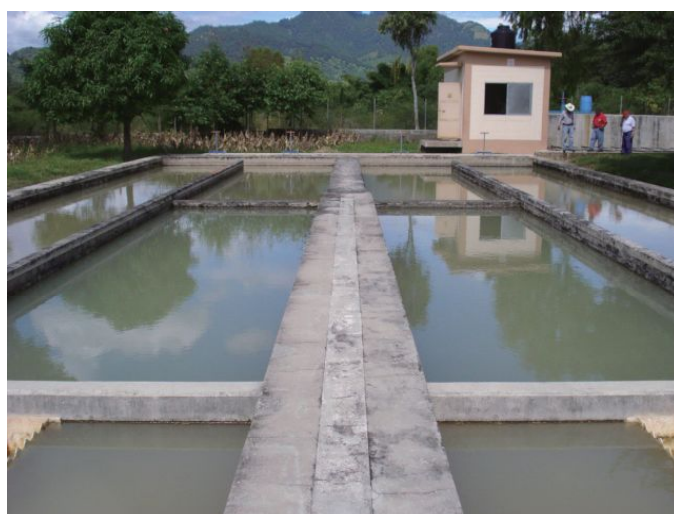
フティアパ浄水場の沈殿池
