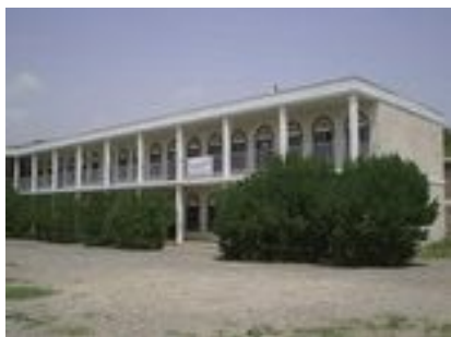
学校外観（建設時には木々はなし）
