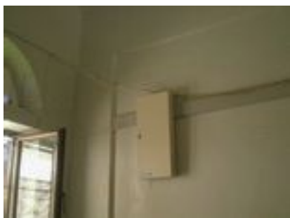
イエメン側による電気整備
