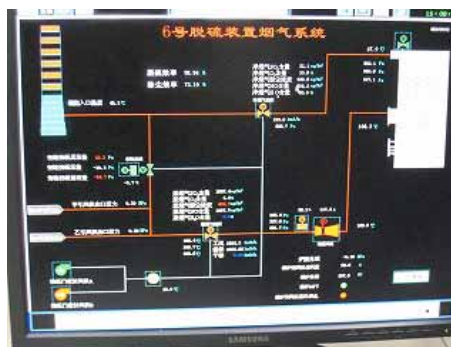
図 5 排煙脱硫装置管理モニタ
