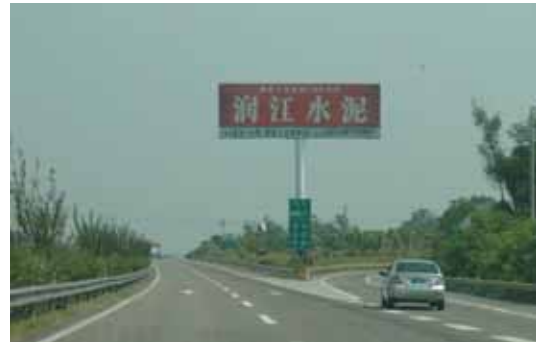
梁平-長寿高速道路
