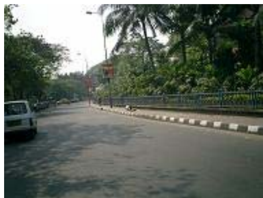
追加工事区間
