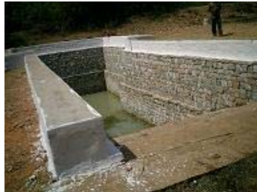
水土保全のための施設
