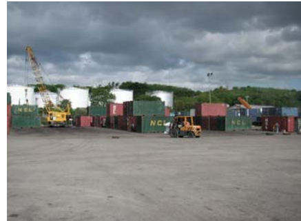
コンテナ・ヤードと本事業で調達された フォークリフトとクレーン（クバン港）
