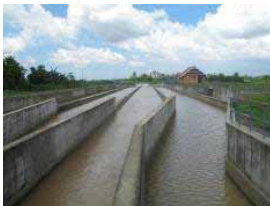
整備されたビスア灌漑スキーム 灌漑一次水路
