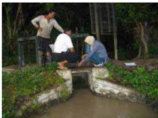
水利組合（P3A）職員による 三次水路の水門の開閉作業
