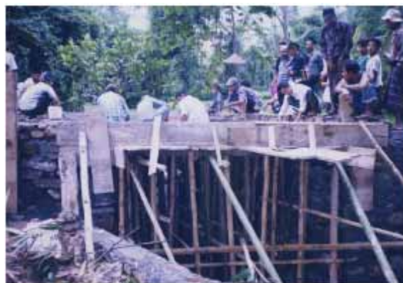
OMSによって建設中の灌漑3次水路（南スラウェシ州）と橋（西ヌサテンガラ州）
