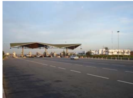
南部バイパス・ステイトメリル料金所
