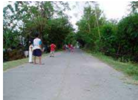
図-9 舗装された堤防（アグノ川右岸）
