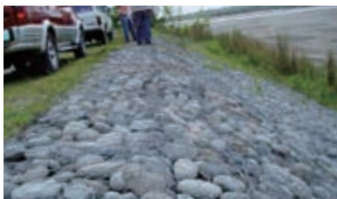
タルラック川右岸堤防修復
