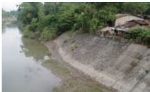
シノカラ川護岸工事
