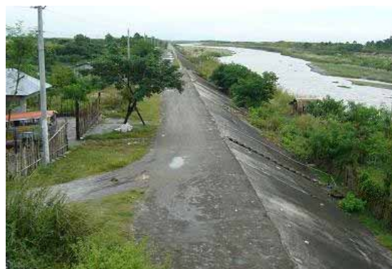
バンバン川護岸補強
