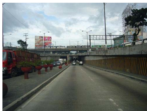
エドサ/ケソン 立体交差 ケソン沿いアンダーパス
