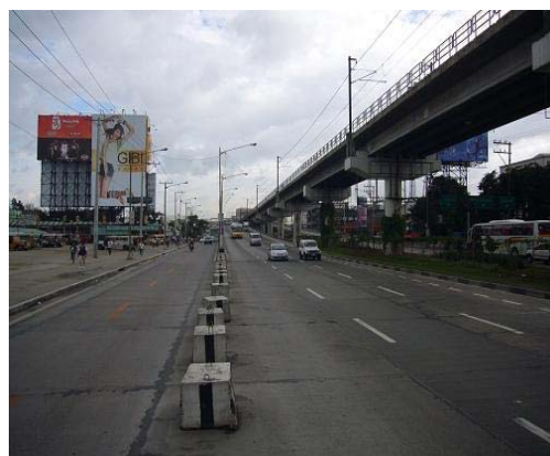
エドサ/ケソン立体交差 エドサ沿いフライオーバー
