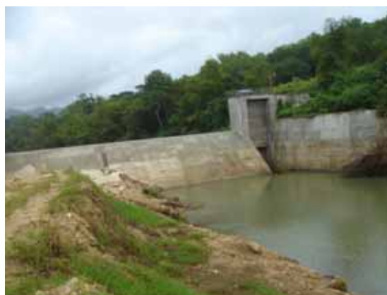
本事業にて建設されたミニ水力発電施設
