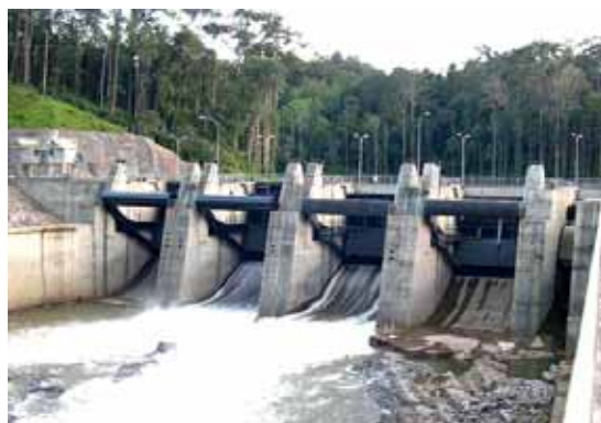
ククレ水力発電所調整池ゲート
