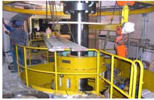
地下発電所下層階（建設中）
