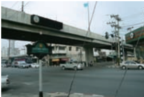
建設された高架橋
