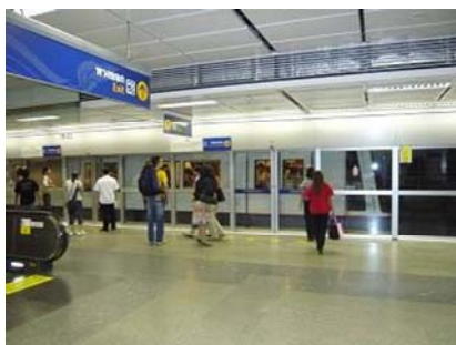
図 2 プラットホームにおけるドアシールドの設置状況
