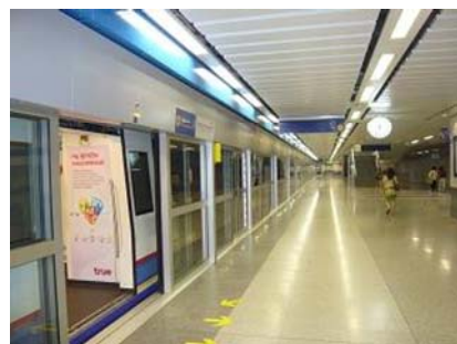
図 2 プラットホームにおけるドアシールドの設置状況
