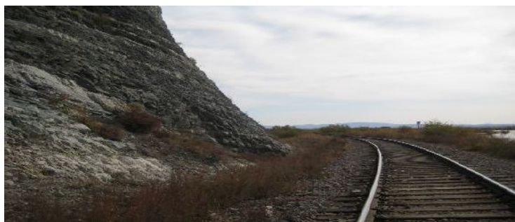
落石対策工事施設（スフバートル地区）
