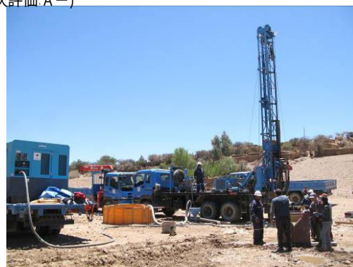
写真 1. 61 村落目の井戸掘削現場（ポトシ県）
