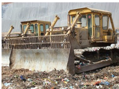
江村溝処分場で活躍中のブルドーザー
