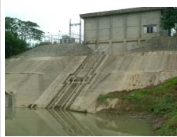
ポンプ場建屋及び取水ロゲート（水中）
