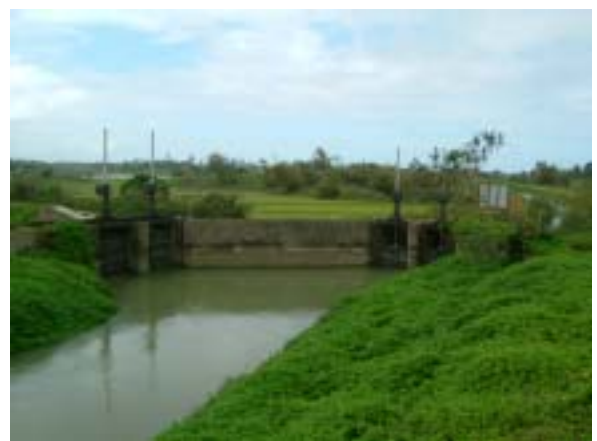
支線分水ゲート
