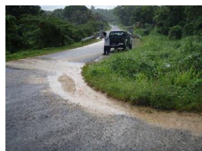
左:ナット欠損部、中:舗装面の破損した反射板、右:雨天時に路面を横切る雨水
