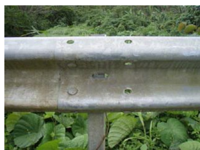
左:ナット欠損部、中:舗装面の破損した反射板、右:雨天時に路面を横切る雨水
