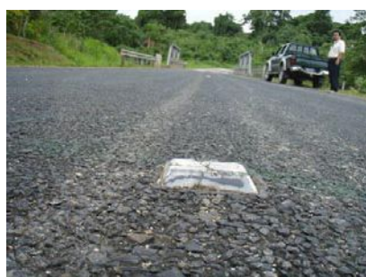
左:ナット欠損部、中:舗装面の破損した反射板、右:雨天時に路面を横切る雨水
