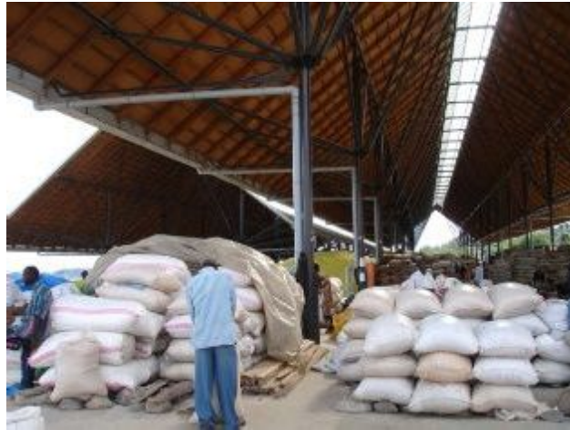
キルンバ魚市場（屋根の布設及び床面を舗装した市場施設）
