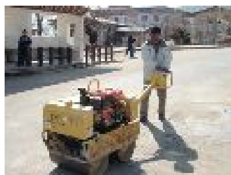
本案件で支援したハンドガイドローラを使った道路補修工事
