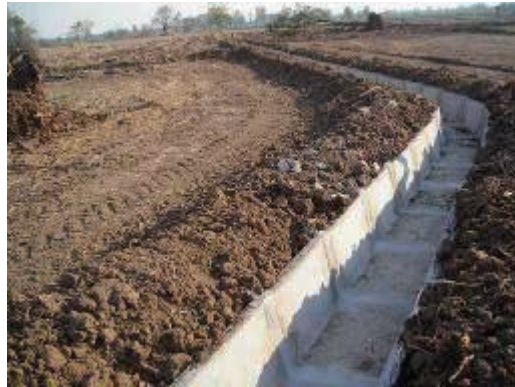
建設中の U 字溝
