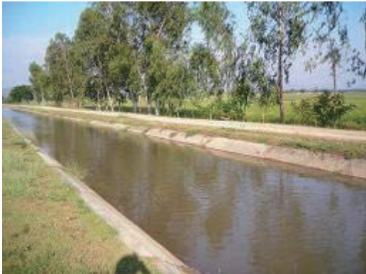
モデルエリアの 18R 支線用水路
