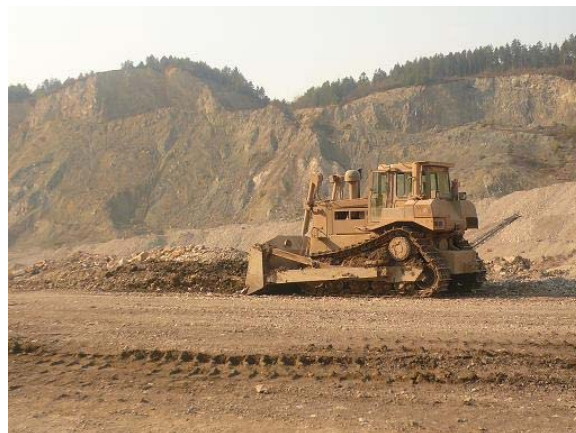
修復されたブルドーザー（バノビチ炭鉱）
