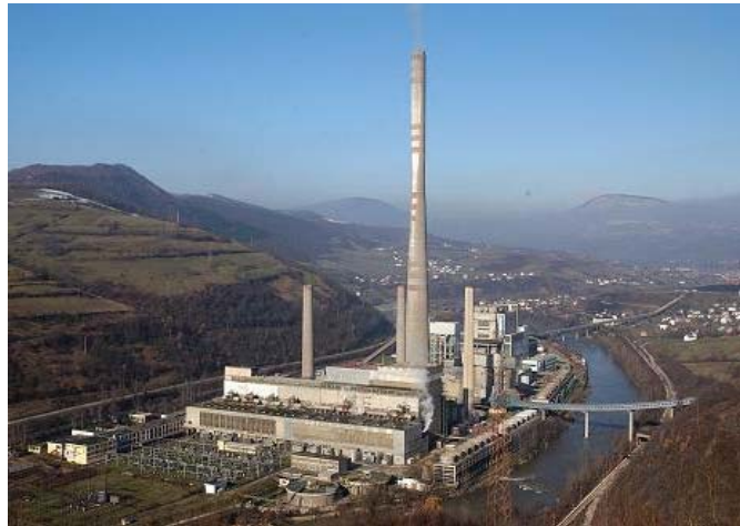
カカニ火力発電所
