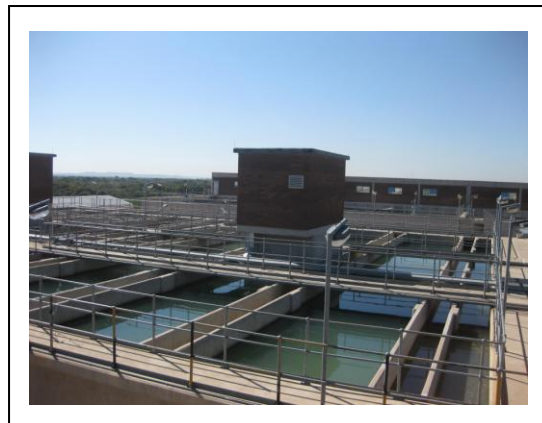
ママシア浄水場
