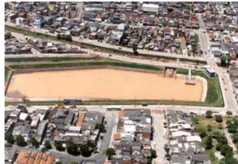
図 7 雨水流出抑制施設（調整池）
