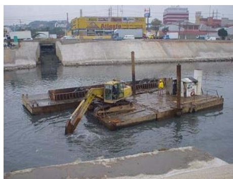
図 17 沈泥除去作業の様子
