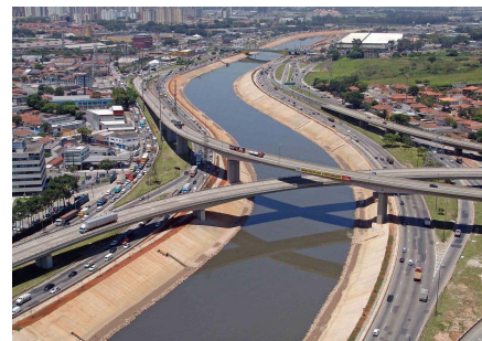
河川改修後のチエテ川
