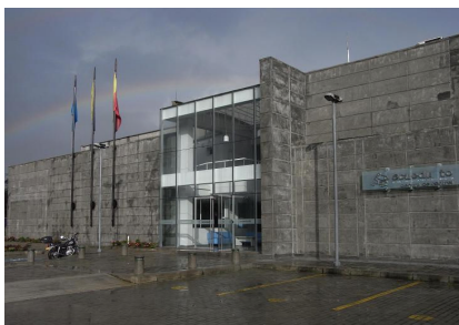
図3 コントロールセンター外観
