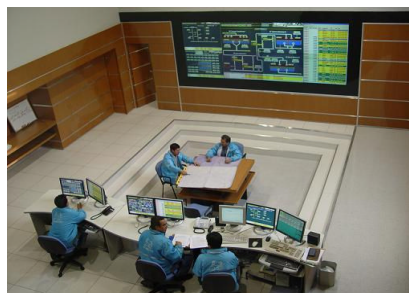
図4 送配水コントロール室
