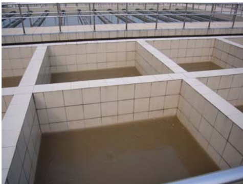
豊収壩浄水場内 沈殿池
