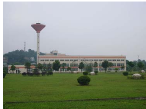
豊収壩浄水場内 貯水池（地下）
