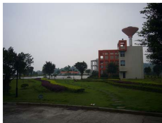
豊収壩浄水場
