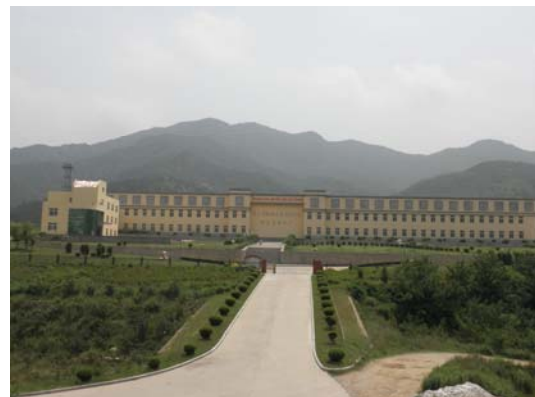
揚家店浄水場
