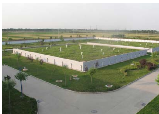
灤南県自来水公司の本事業により整備された貯水池
