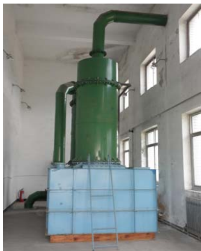
遷西県自来水公司の 本事業により整備された塩素投入機
