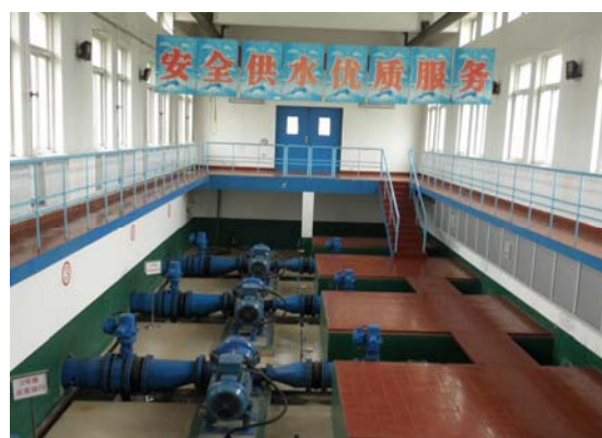
遷安県配水場
