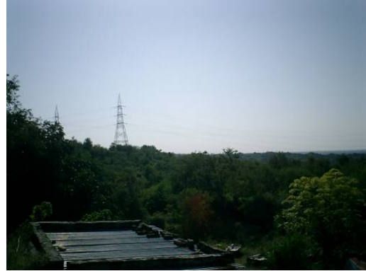
森林地域に建設された送電線
