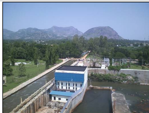
本事業で建設された 小水力発電所（タミルナド州）
