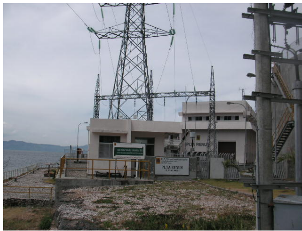
トバ湖畔に立地するルヌン水力発電所
