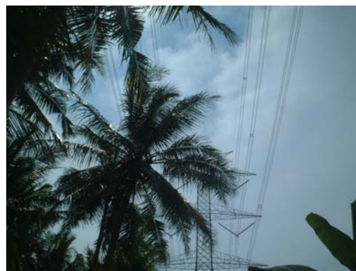
図 7 敷設権未取得地点の状況
