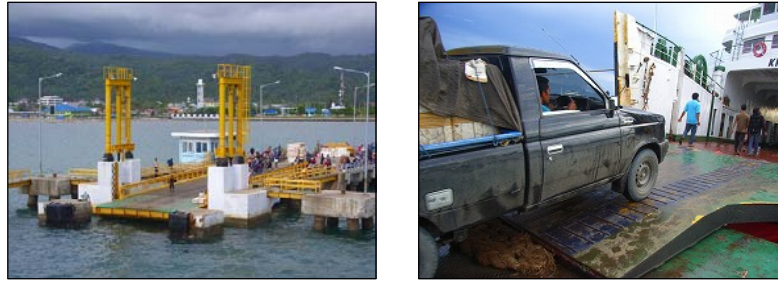
可動橋(左)と可動橋からフェリーに乗船する車両(右) (コラカ・フェリーターミナル)
