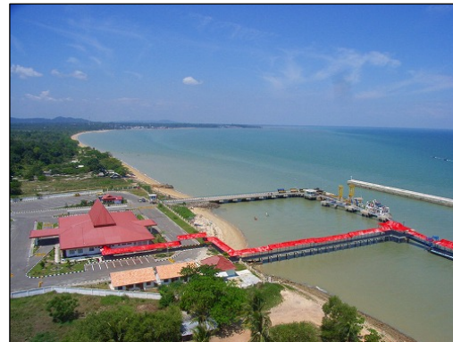
本事業により建設された フェリーターミナル (ムントク)
