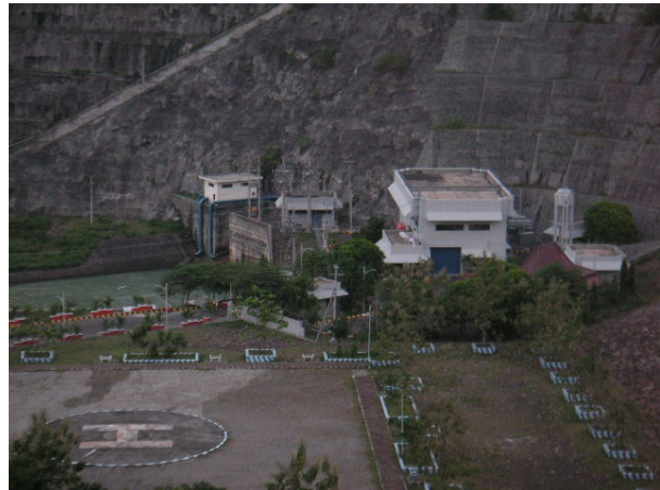
ウォノレジョ水力発電所遠景
