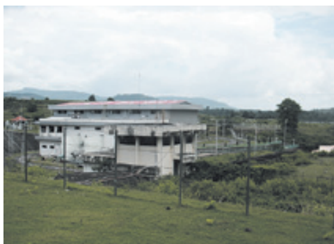
ピリピリ発電所
