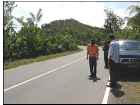
写真 1 ムアラエニム～メラピ間
