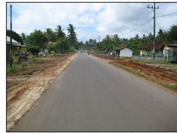
拡幅工事实施中の道路 (ジェパラから南2～3km 地点)
