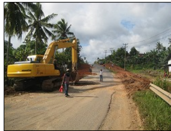
改良工事实施中の道路 (ジェパラから南2～3km 地点)
