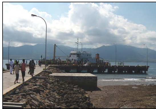
本事業で建設されたメナンガ港の栈橋
