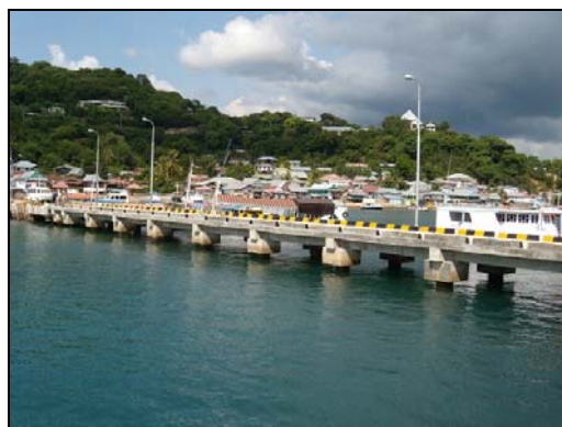
写真3 栈橋(ラブアン・バジョー港)
