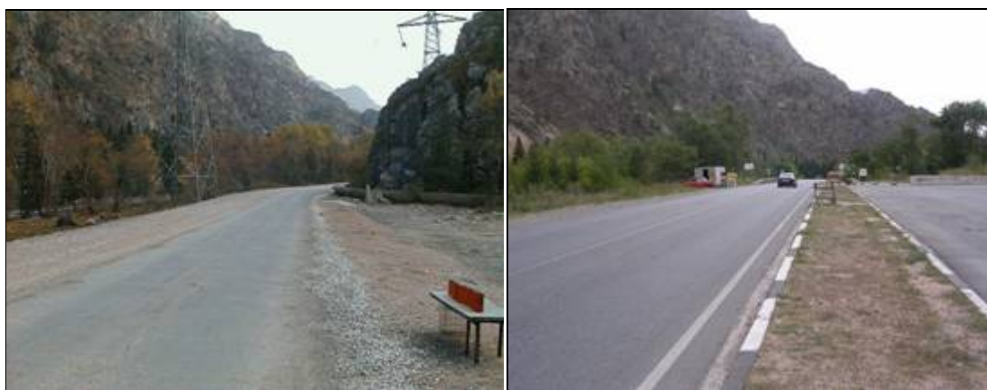
改修工事前の道路状況
