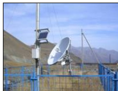
トゥーアッシュトンネルに配置された衛星通信機材
