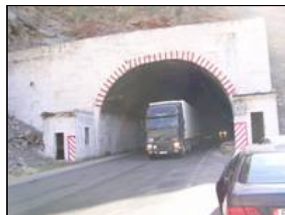
ビシュケクから 415km 地点 にあるトンネル
