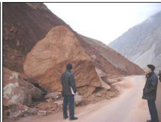
工事中の落石
