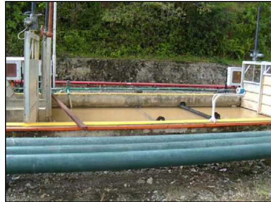
写真 4：砂分離装置
