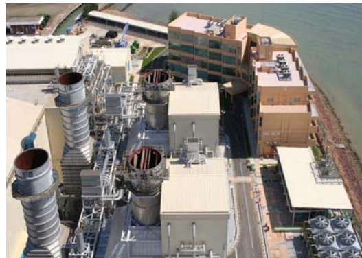
写真 1：発電設備、排水設備等
