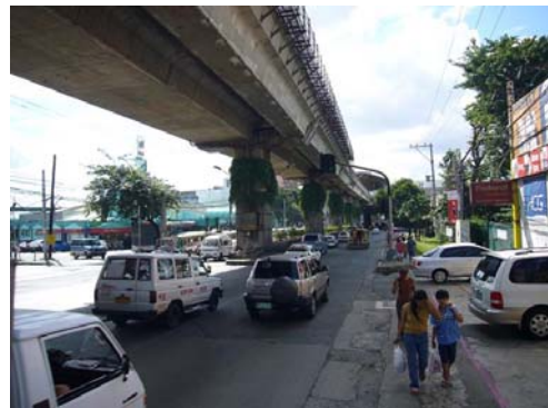
アノナス駅周辺の 2 号線軌道
