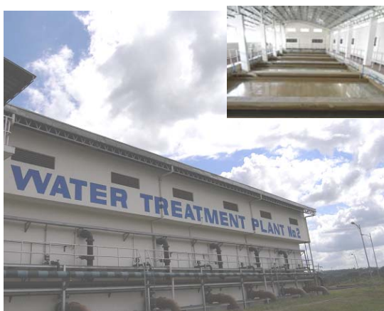
本事業にて設置された浄水施設 (サン・ホセ・デルモンテ市)
