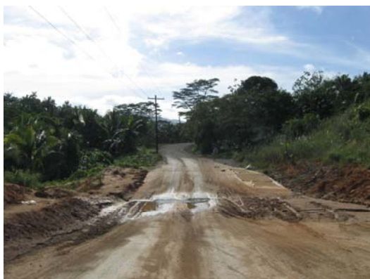
未改修区間の状況 (土道)
