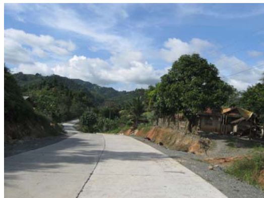
ボンガボンーバレル道路 山間部区間
