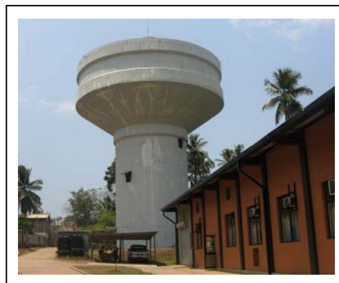
マハラ配水センターの給水塔とポンプハウス
